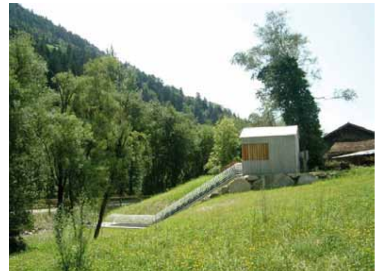
Centrale idroelettrica Weger, St Martin I. P., Thomas Wiedmer
