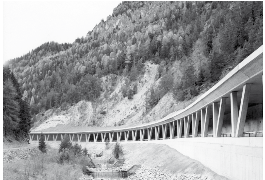
Galleria Paramassi a Trafoi, Stelvio, Siegfried Pohl
