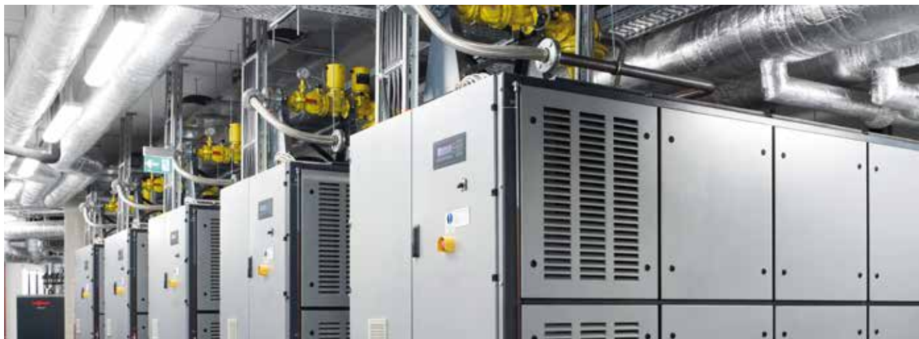
Gruppi di cogenerazione compatti per la produzione efficiente di energia termica ed elettrica
