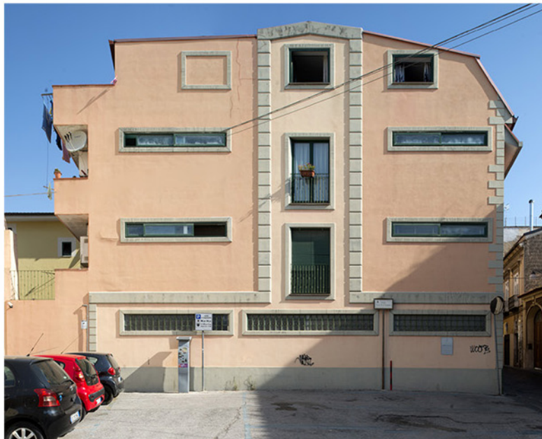
FACCIATA PROSPICIENTE PIAZZA TORRE S. ERASAMO SU CUI DOVRA' ESSERE REALIZZATA L'OPERA
