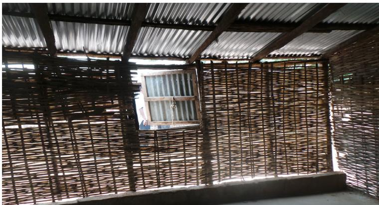
Interno di un'aula. Pareti in bambù intrecciato, zinco per il tetto e pannello metallico per chiudere la finestra.
