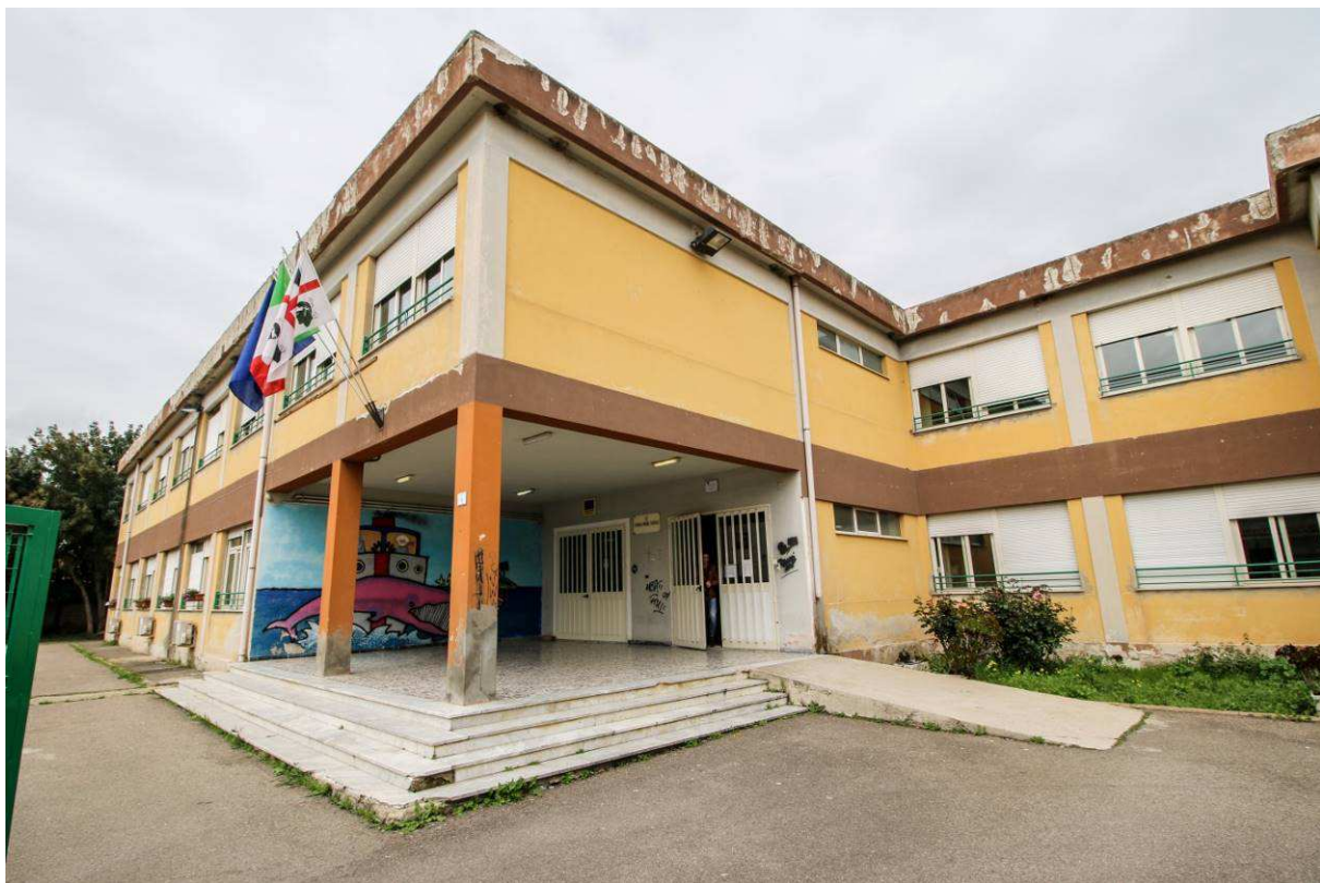
Figura 2: Ingresso della scuola media sulla via Sicilia.
