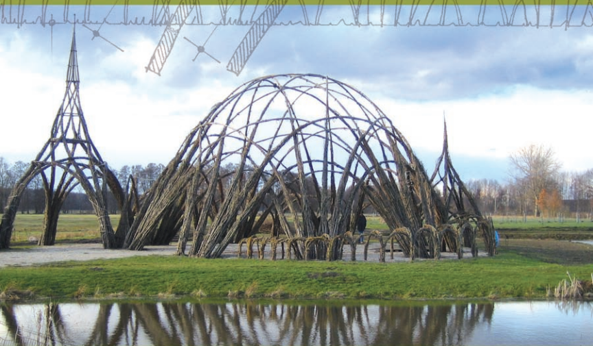
Costruzione in salice - Weidenbau
