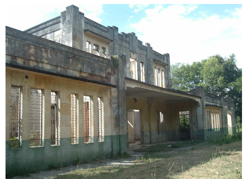
La estación del ferrocarril de Ambalema
