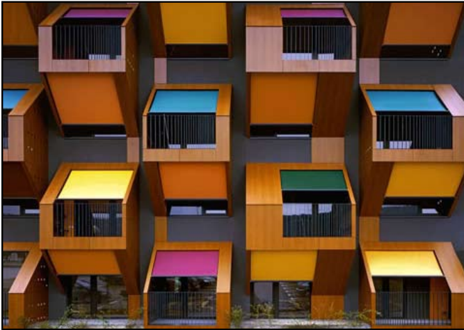
Social Housing Blok, Slovenia - Ofis Architects Fotografia di Tomaz Gregoric
