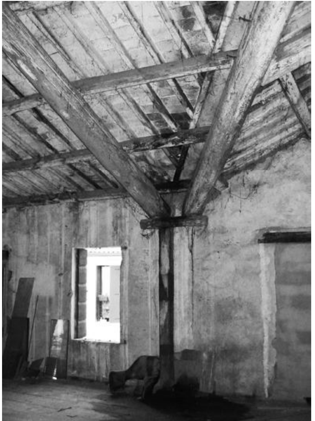
vista interna prima del restauro
