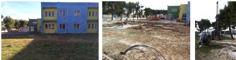
Istituto comprensivo, Melpignano (LE) | ristrutturazione 2014
