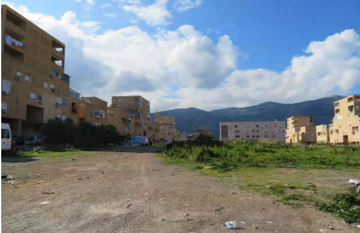
1. Grande vuoto centrale dello ZEN2
